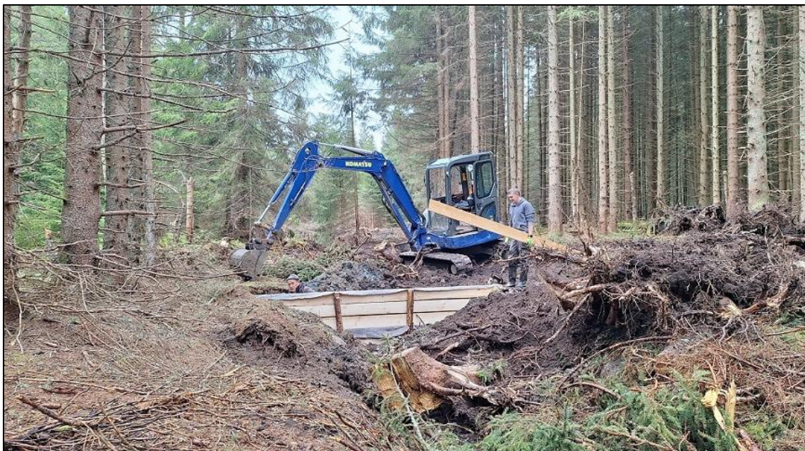
Obrázek 66 Výstavba přehrážky při revitalizaci vodního režimu v PR Najmanka
