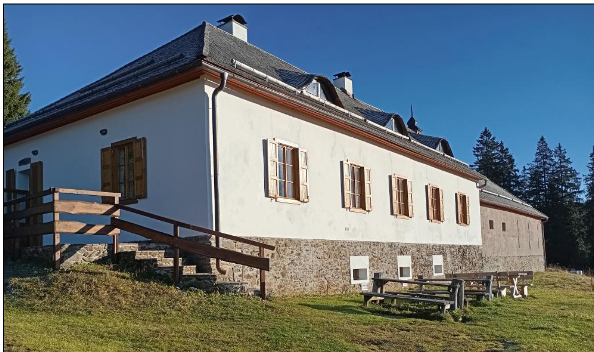
Obrázek 58 Výroba a instalace nových oken, nového zábradlí na Březníku
