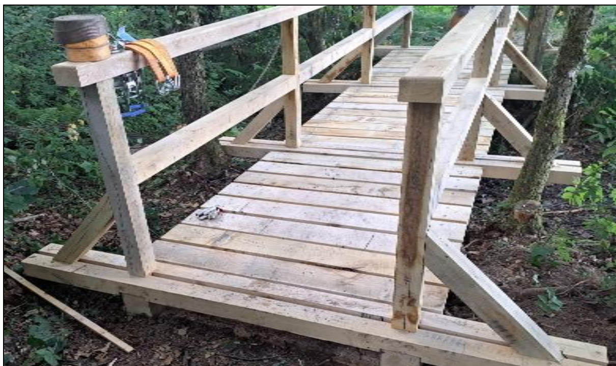
Obrázek 64 Rekonstrukce mostu na NS Hamry
