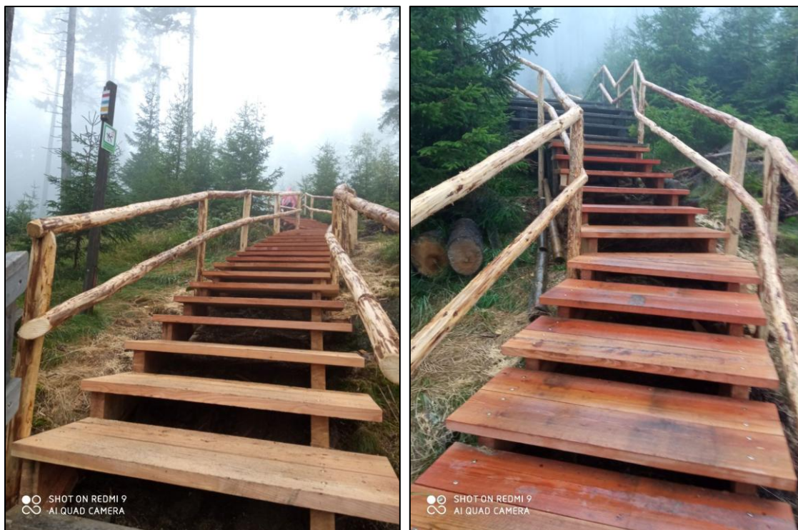
Obrázek 49 Oprava přístupové cesty na vrchol v NPR Boubínský prales.
