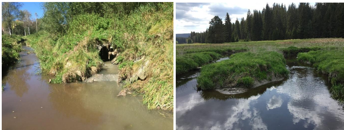
Obr. 10. Vlevo: Únik nečištěné odpadní vody do Volarského potoka z vyústění dešťové kanalizace nad ČOV Volary dne 10.9.2020. Vpravo: v meandrech pod městem se voda ve Volarském potoce mírně zlepší, ale stále se do Vltavy může dostávat silně znečištěná.
