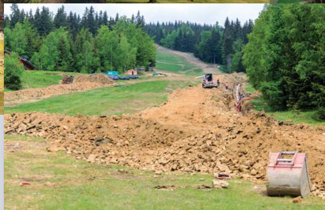
Už pouhá instalace zasněžovacích systémů s výkopy po spádnicí vede k rychlejšímú odvádění vody z dotčeného území. Foto: Petr Flousek
