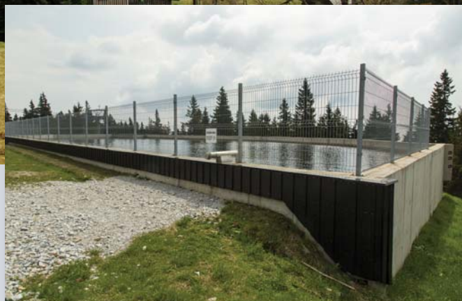
Zasněžovací nádrže bývají krajinnásky problematické. Tato má objem 10 000 m 3 (a ve 1250 m akumuluje vodu čerpanou z 680 m n. m.), řada nových záměrů však počítá s kapacitou více než trojnásobnou. Foto: Kamila Antošová
