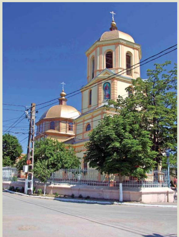
Ve vesničkách delty můžeme spatřit většinou překrásně opravené církevní stavby. Rozvody elektřiny po obcích už tak překrásné nejsou.
