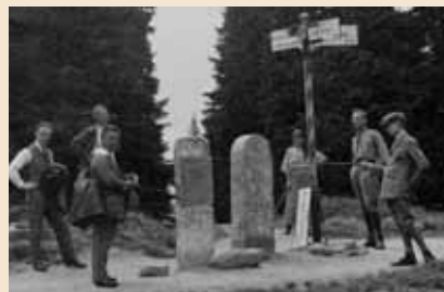
Trojmezník se zapuštěnými deskami ve 20. letech (z české strany).
