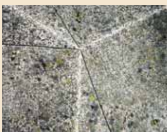
Vrcholová stříška trojmezníku - od průsečíku tří lomových hran stříšky, který představuje trojmezní bod, se ještě rozbíhají černé směrové značky jednotlivých hraničních linií.
