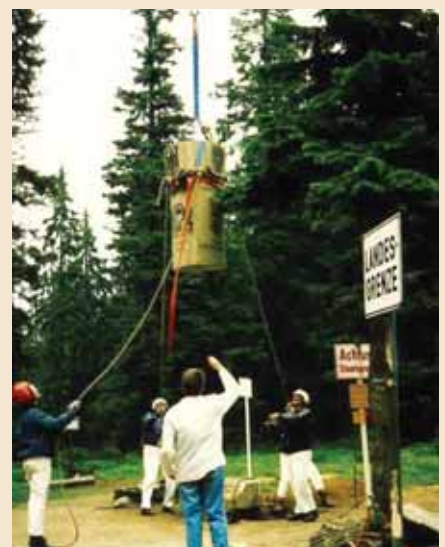
Instalace nového trojmezníku 7. července 1993.
