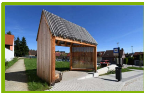
Strunkvice nad Blanicí, autobusová zastávka, City Upgrade
