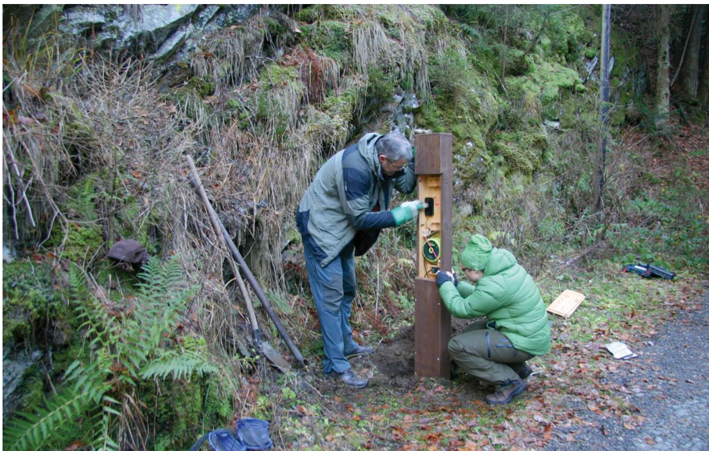
Instalace automatického sčítače na jednom ze stanovišť. (Foto: Josef Štemberk)
