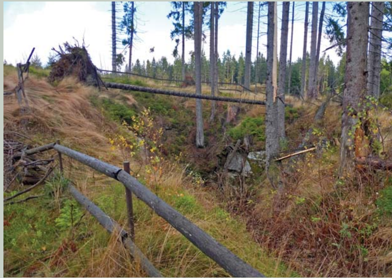
Vstupní část štoly.
