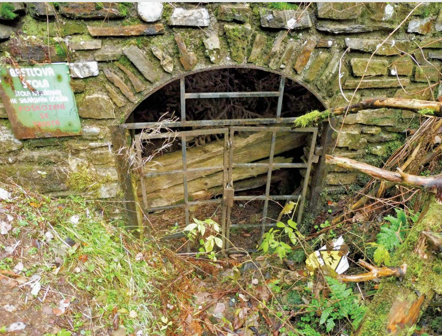
Portál do štoly je zajištěn proti vstupu.
