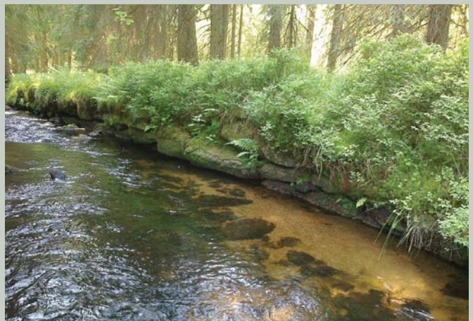
Zpevněné koryto Čertovy vody pro plávku dřeva.
