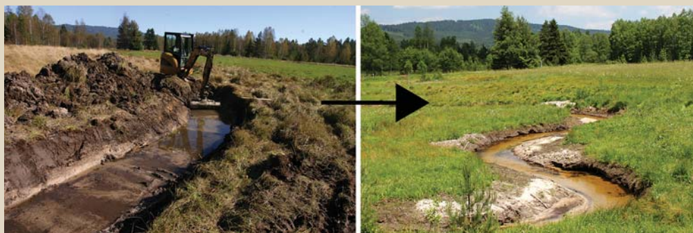
Obr. 2: Stavba nového koryta (vlevo) a jeho současná podoba (vpravo). (Foto: Ivana Bufková)
