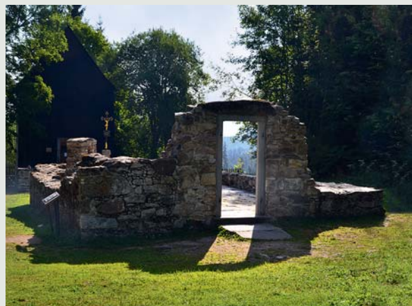
Obnovené základy zbořeného kostela sv. Vincence Ferrerského a hřbitovní kaple Povýšení sv. Kříže.
