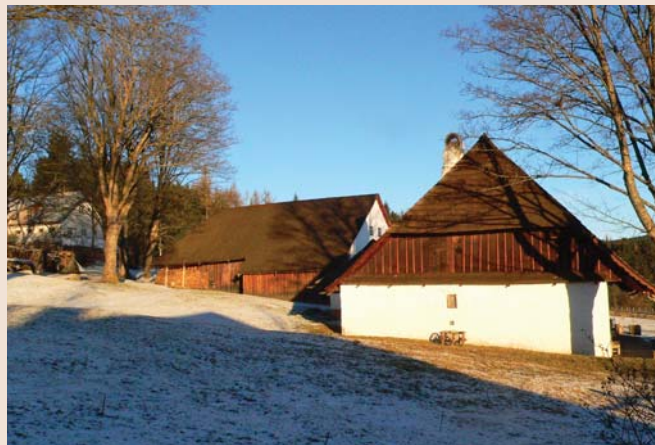
Chalupy u Stach - památkově chráněný objekt, u něhož vedle historické a architektonické hodnoty stojí za pozornost také jeho osazení v terénu.
