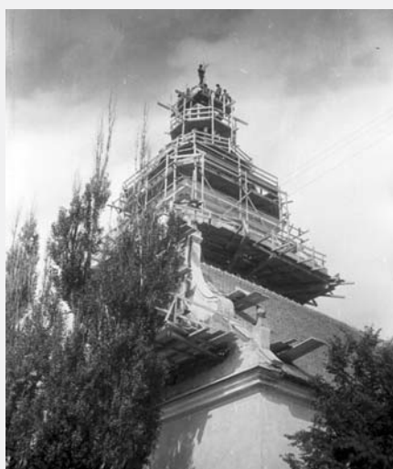
Volar, oprava věže kostela sv. Kateřiny. Foto: František Seidel, 2. 9. 1930.
