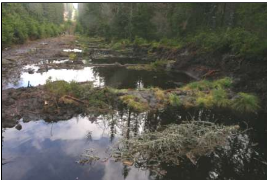
Zablokovaný odvodňovací kanál vyplněný vodou na signálce pod Černoohorským močálem (foto: Iva Bufková, 2014)
