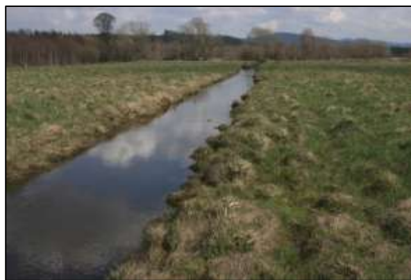
Zkanalizované úseky Žlebského potoka před revitalizací (foto: Iva Bufková, 2014)
