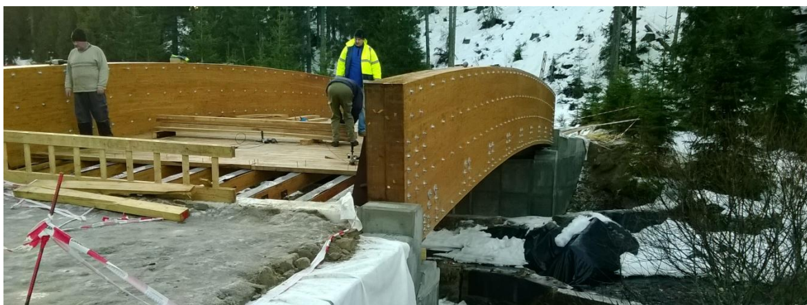
Stavba mostu pro usměrnění běžeckého lyžování na Modravě (foto: Jana Slonková)
