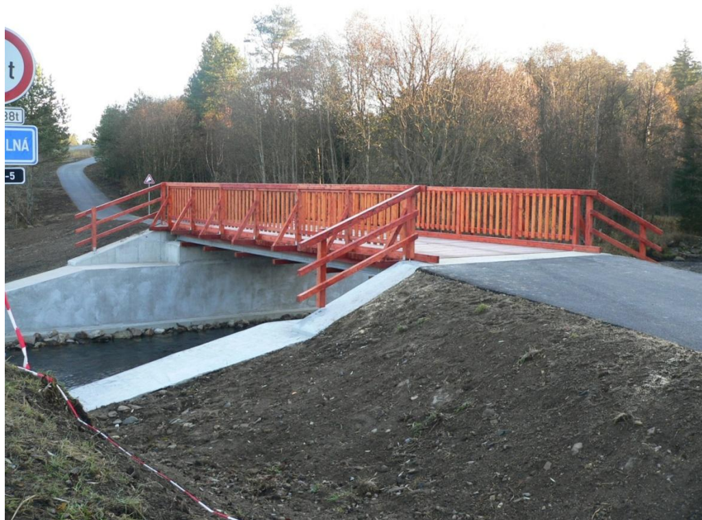
Most přes Křemelnou na nově postaveném úseku II/B (foto: Jana Slonková)
