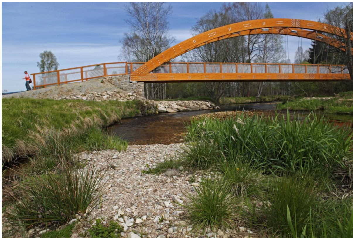
Obnovená lávka Černý Kříž přes Studenou Vltavu (foto: Štěpán Rosenkranz)
