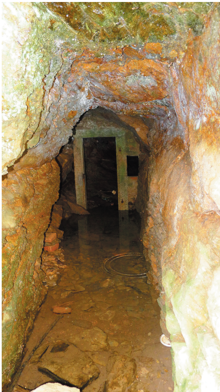
Obr. 9. Úvodní část štolové chodby (rok 2011). Fig. 9. Photo of the entrance part of the gallery (2011).
