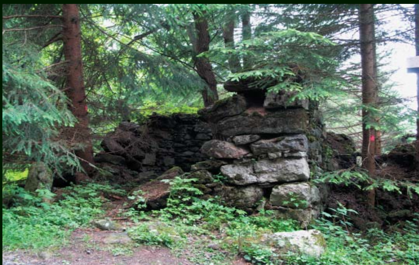
Malá kaple – před započítím prací
