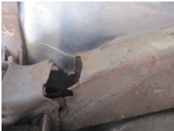
Totální koroze nosníku
